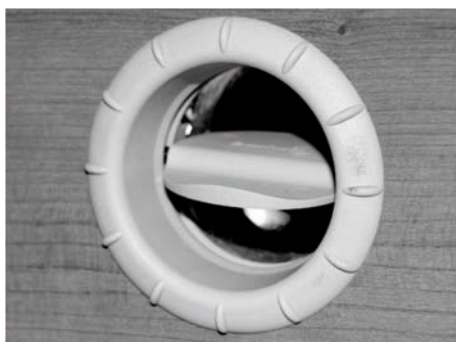
Bild 78: Varmluftspjäll, öppet
