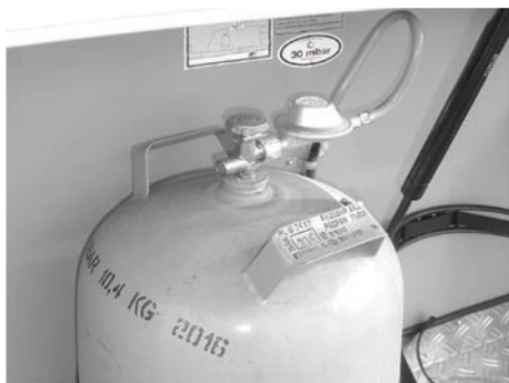
Bild 73: Gasolflaska med lågtrycksregulator och lågtrycksslang
