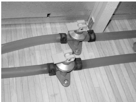
Bild 160: Stängda avtappningsventiler
