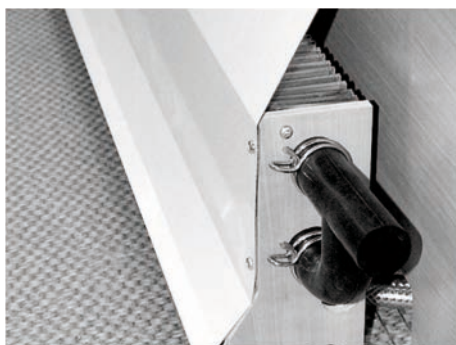
Bild 85: Konvektor med värmeledningsplåt
