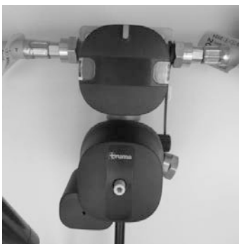
Bild 107: Gasolsystem DuoControl CS
