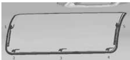
Bild 31: Vy invändigt av välvt utåt öppningsbart fönster med fem låsvred
