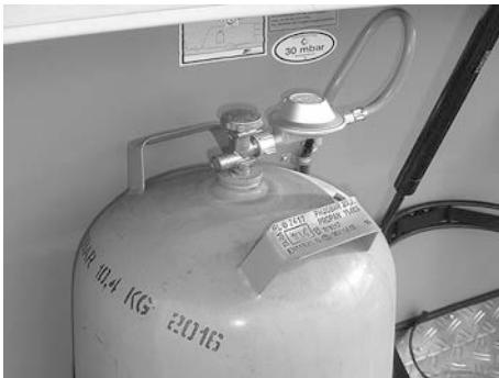
Bild 106: Gasolflaska med tryckreducerventil
