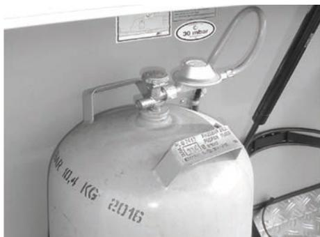
Fig. 73 : Bouteille de gaz avec détendeur basse pression et flexible basse pression
