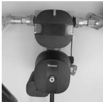
Fig. 74 : Alimentation en gaz (avec Eis-Ex et téléaffichage)
