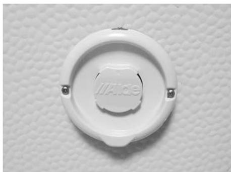
Fig. 83: Conduit d'évacuation des gaz brûlés (sur la paroi)
