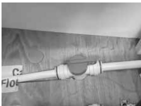
Fig. 91 : Vanne du chauffage au sol ALDE
