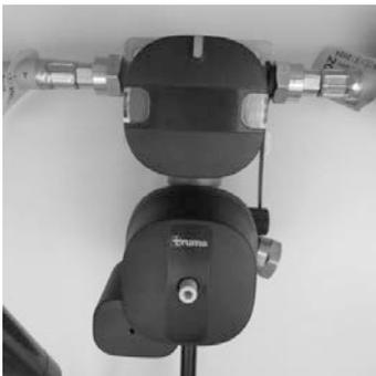
Fig. 107 : Alimentation en gaz DuoControl CS
