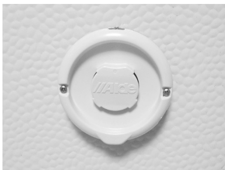
Fig. 82 : Conduit d'évacuation des gaz brûlés (sur la paroi)
