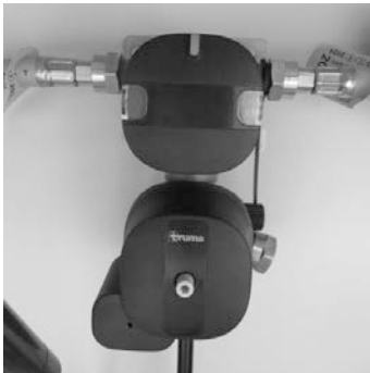
Fig. 109 : Alimentation en gaz DuoControl CS
